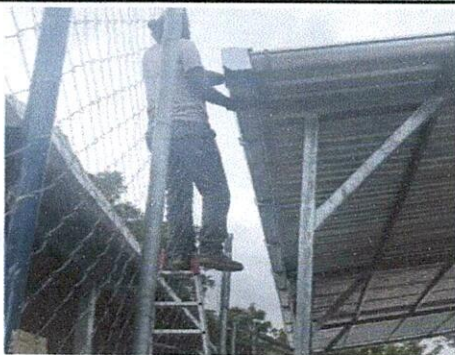
Foto: 5 Proceso de instalación de canal de agua pluvial
