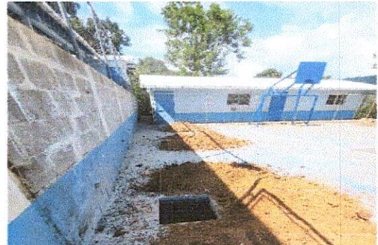
Foto: 2 Excavación para mejoramiento de cubierta de techo con lámina troquelada calibre 26 para cancha
