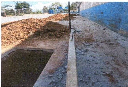
Foto: 3 Trazo y estaqueado para zapatas
