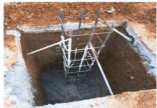
Foto: 4 Fundición y armado de pedestales
