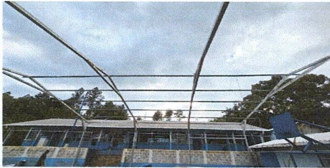
Foto: 1 Corte, soldadura y montaje para estructura metálica tipo pórtico
