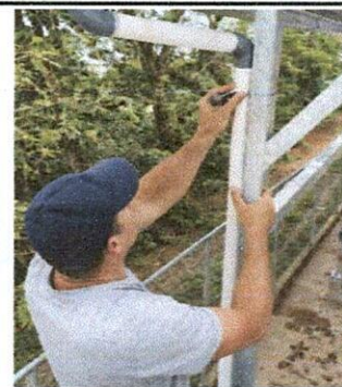
Foto: 6 Proceso de instalación de bajada de agua pluvial
